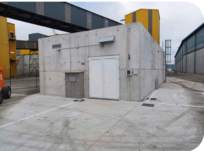
Depósito de recogida de pluviales. Rainwater collection tanks.
