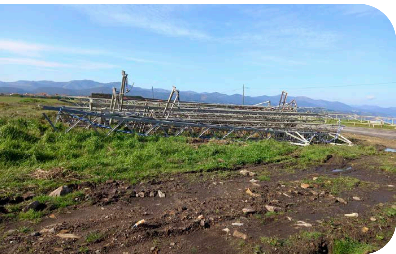
Desmantelamiento línea antigua. Dismantling of the old line.
