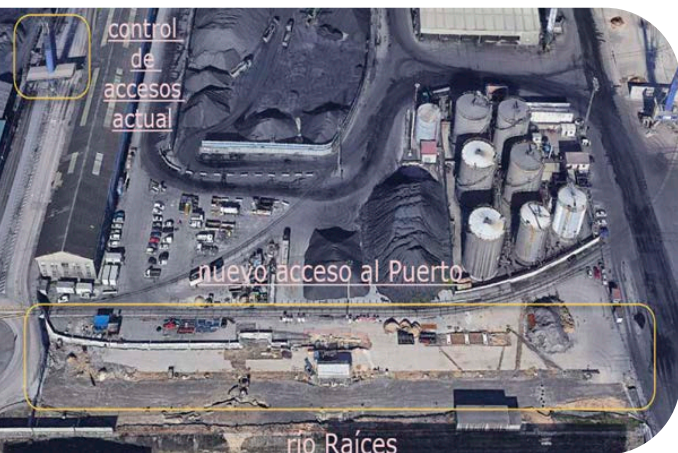
Vista aérea del estado final de las obras. Julio de 2021. Overview of the current access control point and the new access point to execute.
