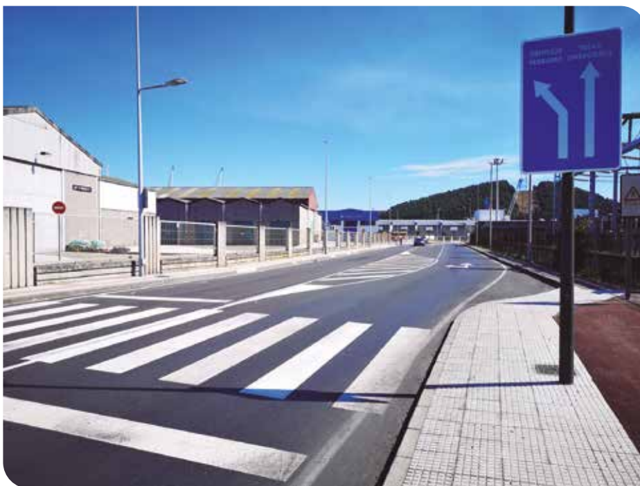
Vista de la obra finalizada en nuevo acceso a zona pesquera. The completed works on the new access to the fishing area.
